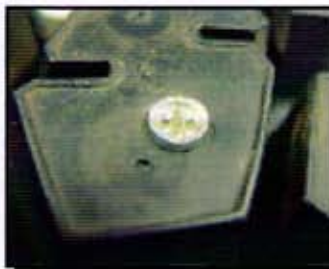
Bonne épaisseur après la pose
