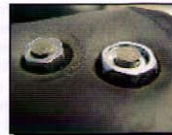
Bonne épaisseur après la pose
